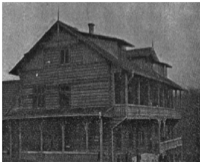
Rycina 2. Sanatorium dra Żurakowskiego (S.A. Lewicki, M. Orłowicz, T. Praschil: Przewodnik po zdrojowiskach i miejscowościach klimatycznych Galicyi . Lwów 1912, s. 198)
